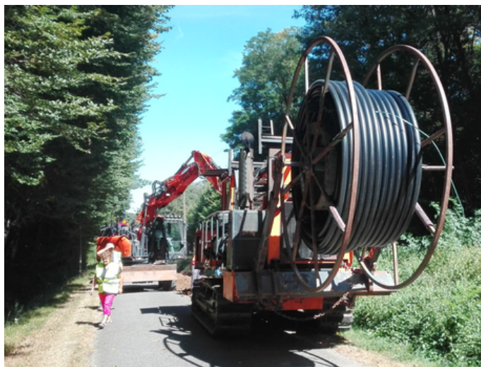
Pose des nouvelles canalisations à la trancheuse
