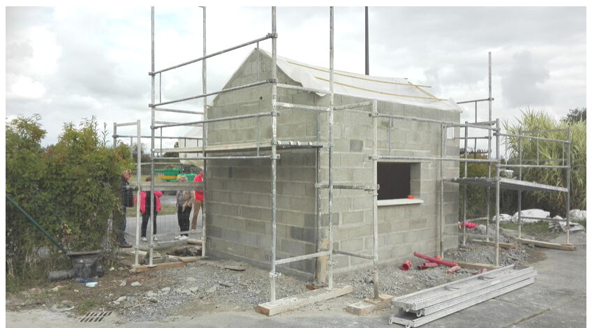
La station de surpression en construction
